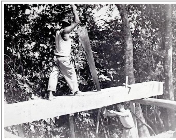
pequeños. Para lograrlo, se construía una plataforma cerca del árbol cortado y se rodaban las trozas encima. Luego se marcaban con un cordón cubierto de carbón y se aserraban. El hombre de arriba subía el serrote y el de abajo lo halaba.
