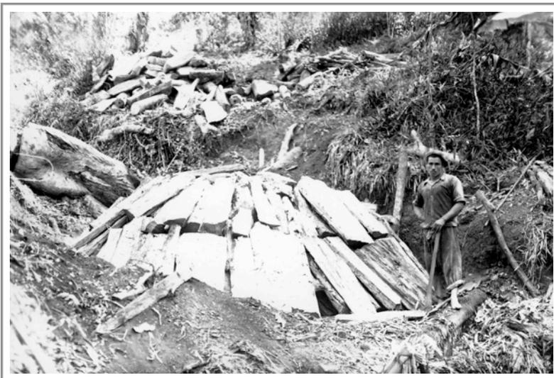
proceso necesario para controlar el flujo de aire durante la conversión. El proceso de quemar la leña hasta convertirla en carbón, cubierta, botando vapor y humo, tardaba dos o tres días. Mientras tanto, la presencia continua del carbonero era necesaria para evitar que entrara demasiado aire, lo que produciría un fuego que consumiría la leña. El carbonero o su hijo pasaban las noches en una hamaca cerca del lugar. El carbón, todavía tibio, se colocaba en sacos
